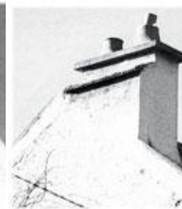
55. Sammeron : la souche prolonge le pignon, puis s'en détache.
