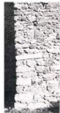
65. Saint-Germain-sur-Doue : la partie basse de ce pignon a des joints creux. La partie haute est enduite "à pierres vues".
