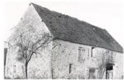
64. Vanry, à Jouarre : façade entièrement beurrée, laissant paraître presque toutes les pierres. C'est l'aspect le plus fréquent dans cette région.
