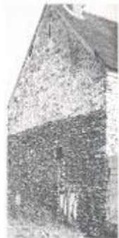
65. Saint-Germain-sur-Doue : la partie basse de ce pignon a des joints creux. La partie haute est enduite "à pierres vues".
